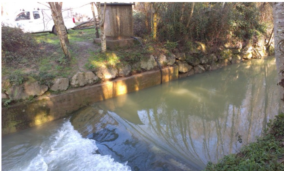
Fig. 2.1.- Aforo estazioa. Aldatutako Crump motako isuribideduna (SA06-Olalde Iturburua)
