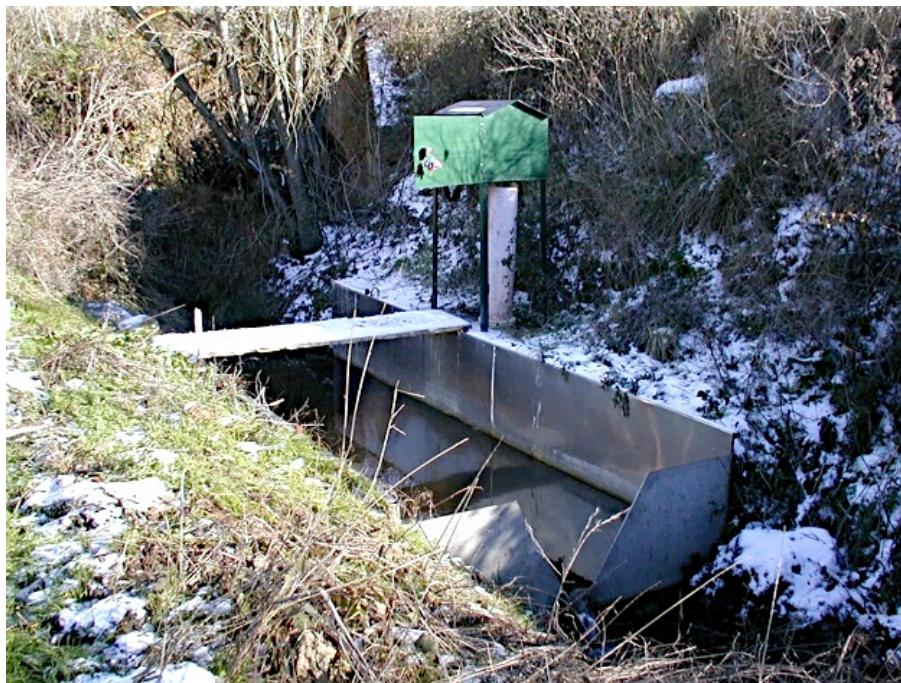
6.1. Irudia- Arreo Sarrera aforo-estazioa (90ºtako hiruki formako isuribideduna)
