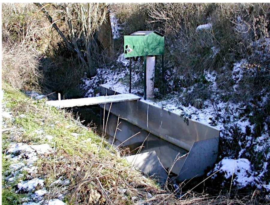
6.1. Irudia- Arreo Sarrera aforo-estazioa (90ºtako hiruki formako isuribideduna)
