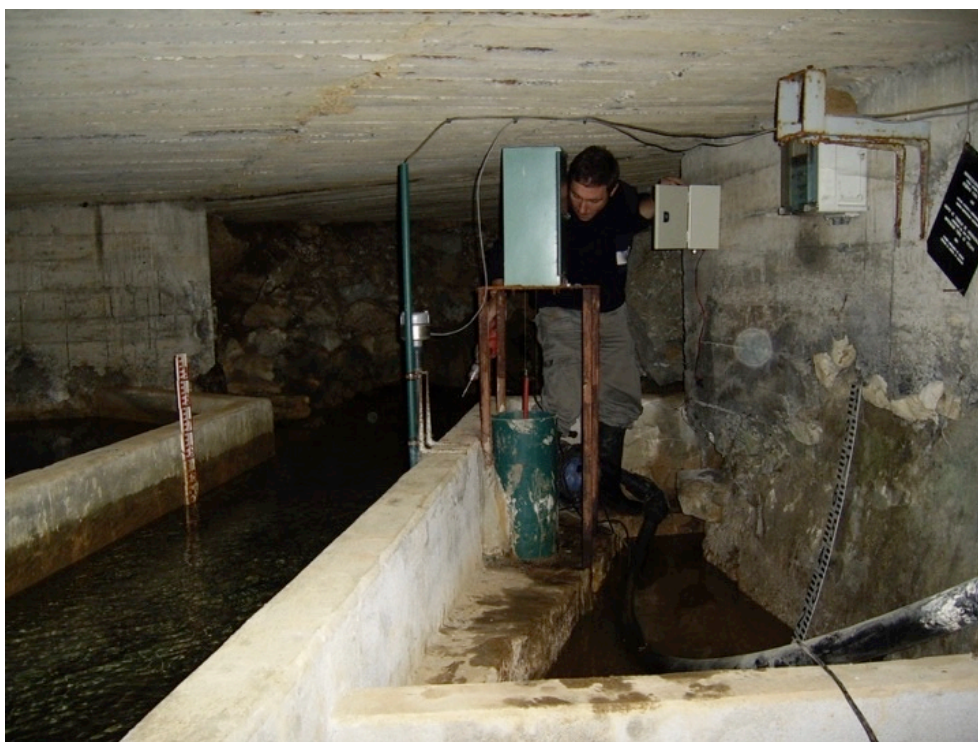
2.1. irudia- SA16-Orue manantialeko aforo estazioa.
