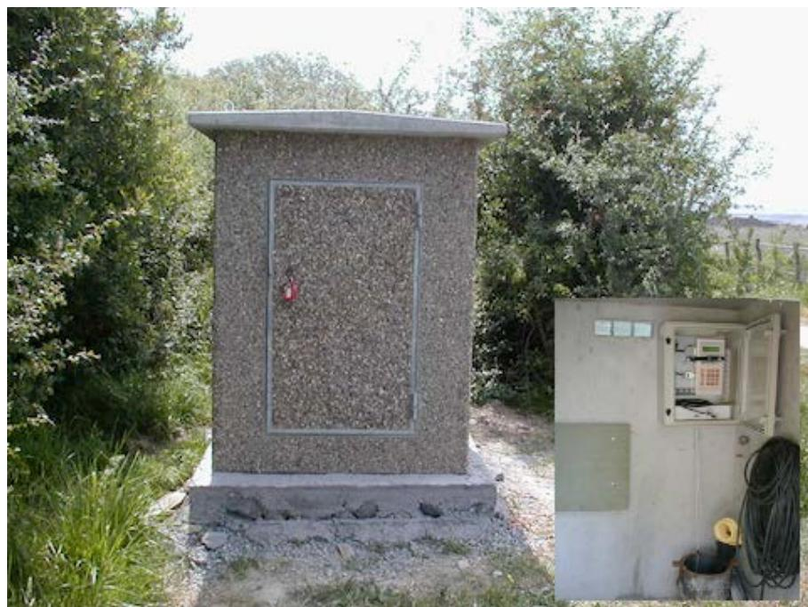
Fig. 2.2.- Estación de control piezométrico tipo (SP13-Sondeo Salburua-1)
