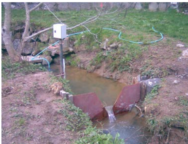
Fig. 7.1.- Aspecto de la estación de aforo del manantial Angela (Vertedero Triangular 60°)
