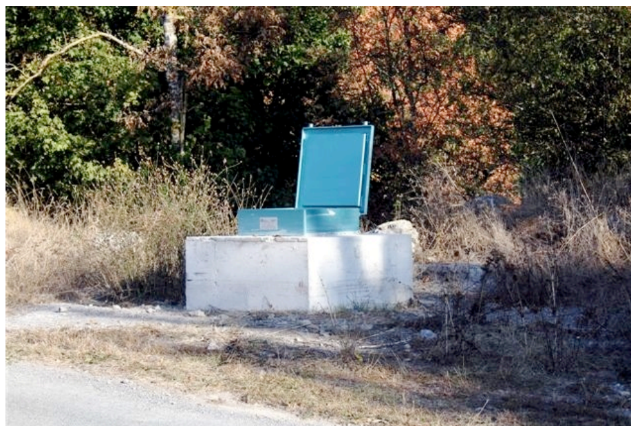
Fig. 2.2.- Estación de control piezométrico con equipo compacto (SP29-Sondeo Andagoia)
