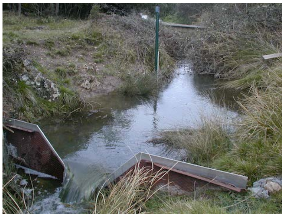
Fig. 6.1.- Aspecto de la estación de aforo Arreo Salida (Vertedero Triangular 90°)
