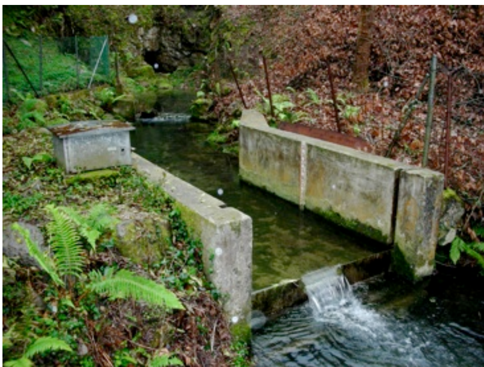
Fig. 2.1.- Estación de aforo tipo. Vertedero rectangular (SA15-Manantial Iturriotz)
