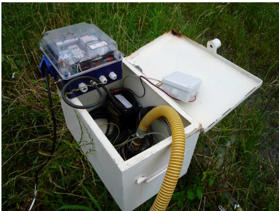
Fig. 2.2.- Estación de control piezométrico SP17-Sondeo HERNANI.
